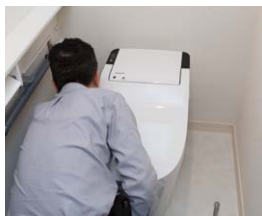
4 アラウーノ 本体設置
