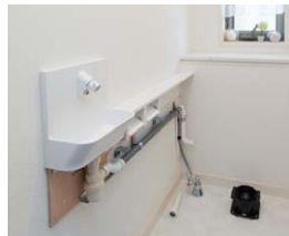
3 手洗い・ カウンター設置
