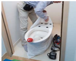
1 養生・ 既存便器撤去
