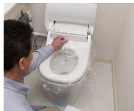
6 通水・漏水検査 試運転
