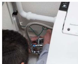
5 給水・電源 接続
